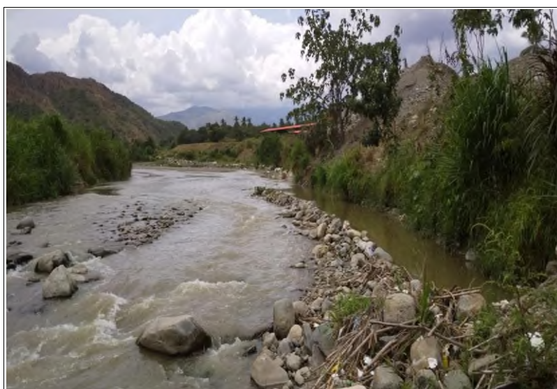
Fotografía N° 02: Colmatado de la Bocatoma canal Yanuyacu, quebrada JAEN o AMOJU.
