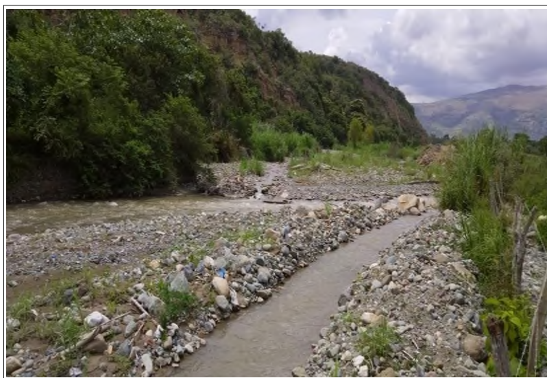
Fotografía N° 02: Colmatado de la Bocatoma canal Yanuyacu, quebrada JAEN o AMOJU.
